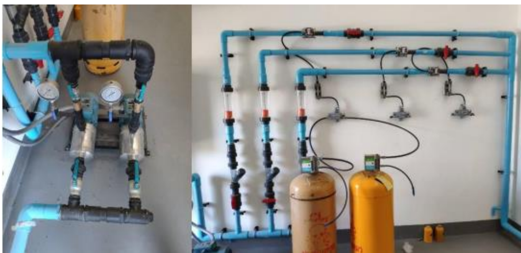
ภาพที่ 1.1 – ระบบคอลรีนที่ใช้น้ำจากการบำบัด
