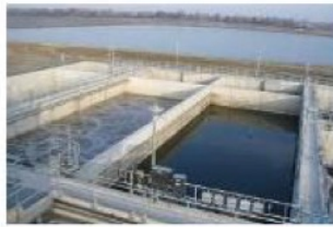
CH4 ระบบบำบัดน้ำเสีย
