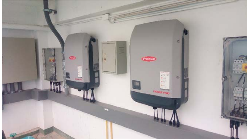
รูปที่ 2.9 รูปภาพติดตั้งอินเวอร์เตอร์แล้วเสร็จ
