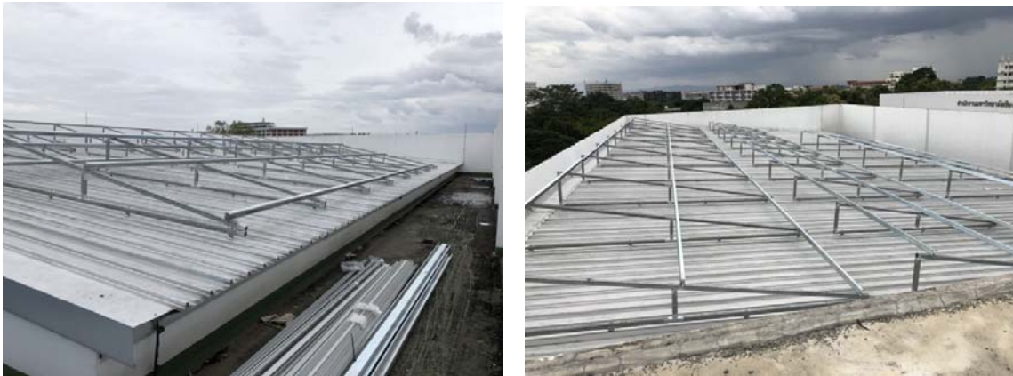
รูปที่ 2.7 รูปภาพงานโครงสร้างรองรับและอุปกรณ์จับยึดแล้วเสร็จ
