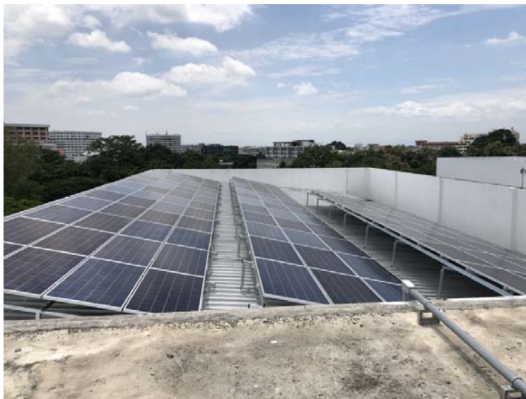
รูปที่ 2.8 รูปภาพงานติดตั้งแผงรับรังสีจำนวน 84.48 กิโลวัตต์แล้วเสร็จ
